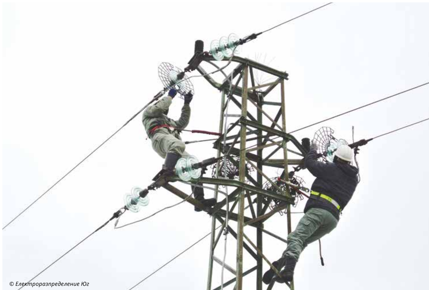
Монтаж на защитни решетки по стълбове на въздушни електропроводи
