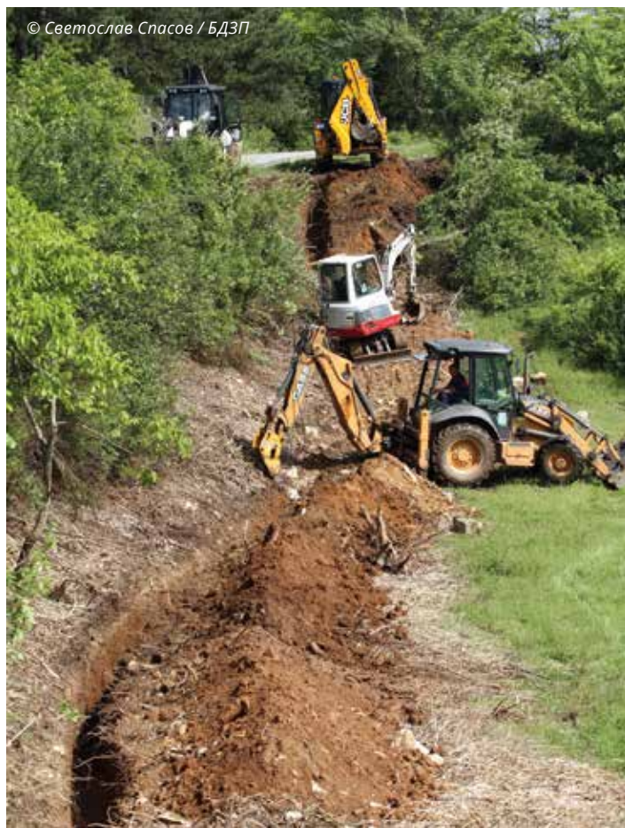
Изкопи за полагане на подземни електрически кабели
