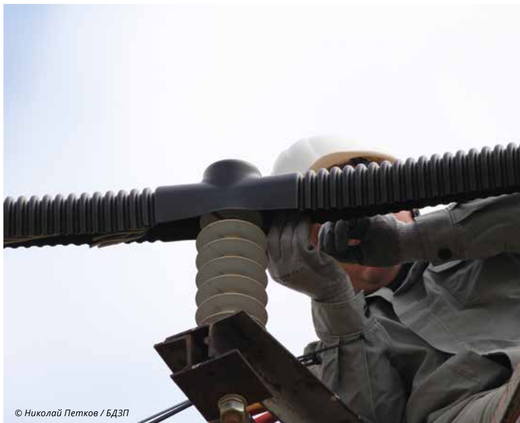
Монтаж на изолации по стълбове
